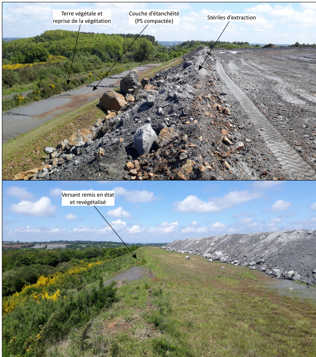
Illustration de la remise en état de la Verse e Kerroué (photographies GEO+, mai 2020)
